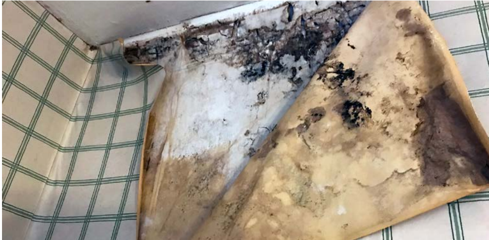
Abbildung 4: Verdeckter Schimmelschaden, Befall unter Tapete (Quelle: P. Tappler, IBO Innenraumanalytik OG)
